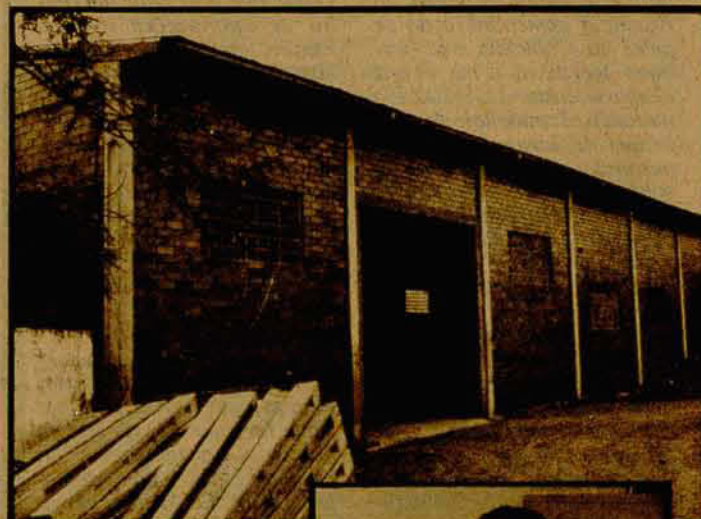
Vista parcial do prédio que a Metalim oferece aos seus colaboradores como um novo e moderno refeitório. A obra está em fase de conclusão.
