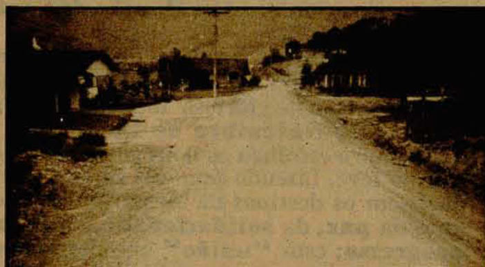
Obras de alargamento e retificação de estradas do interior do município.
