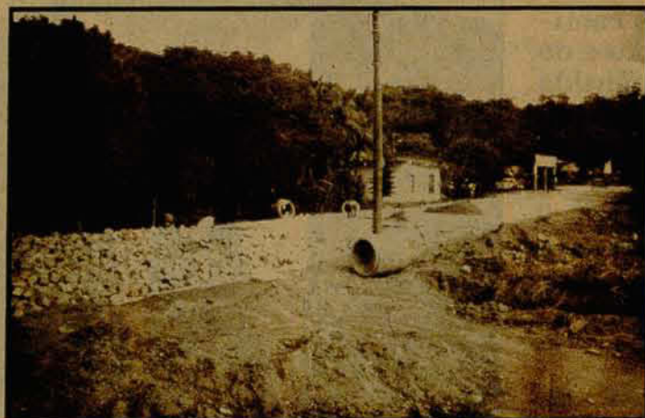
Obras de calçamento a paralelepípedos no perímetro urbano do município.
