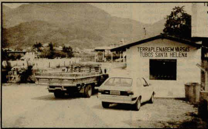
Divisão de produção de tubos de concreto da TUBOS SANTA HELENA, uma empresa de destaque do "pool" de firmas de Ildo Vargas.
