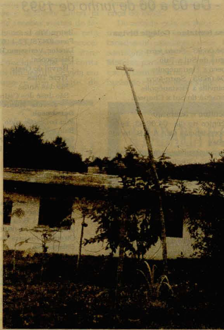
Em alguns loteamentos, a disposição dos fios de energia elétrica, não apresentam condições de segurança.
