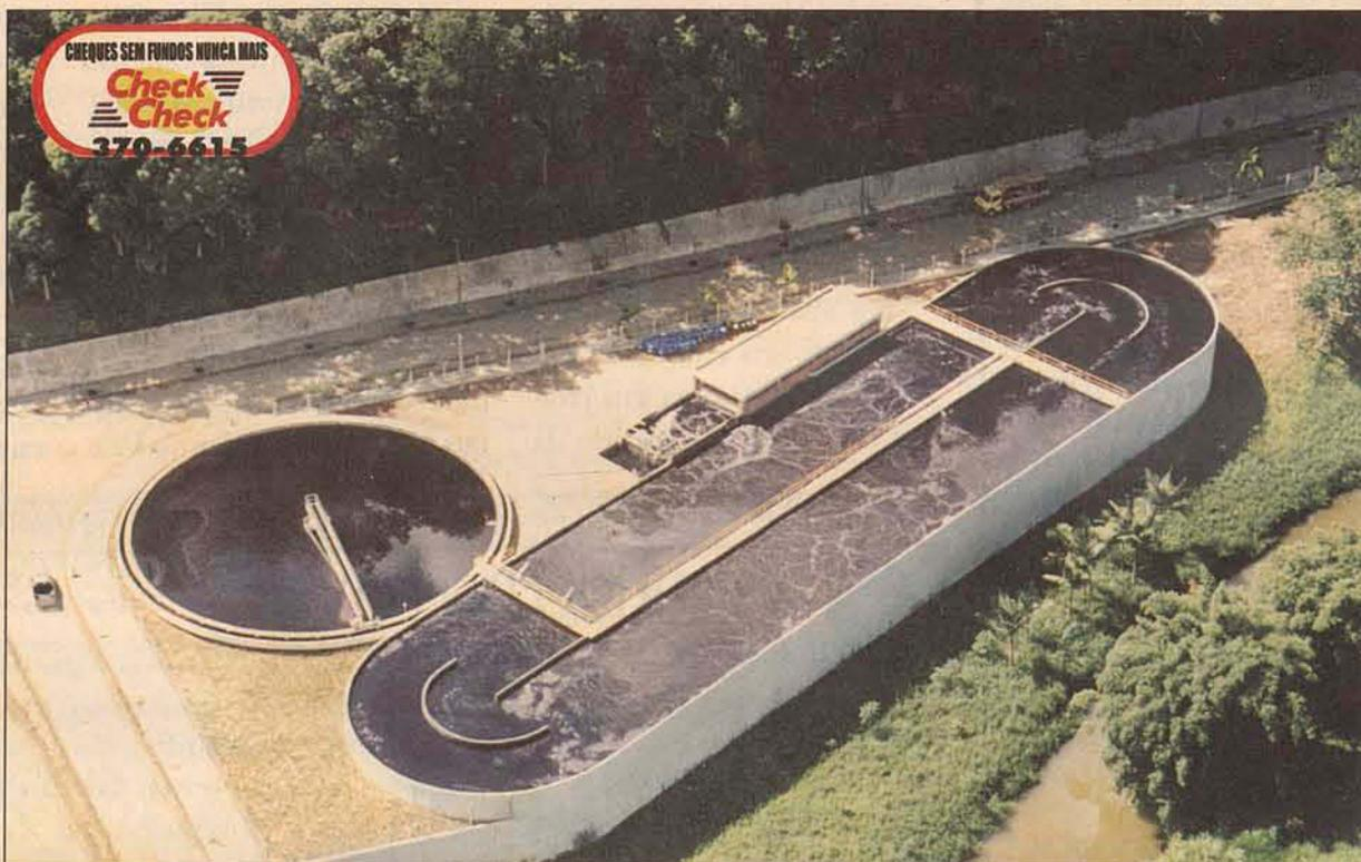
Estação biológica de efluentes industriais, da Malwee Malhas, tem dois tanques: o retangular, para homogeneização e oxidação do efluente, e outro para oxidação do líquido
