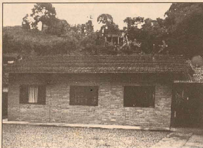
Casa em alvenaria (3 dormitórios), c/ área 250 m 2 , em terreno de 603 m 2 . Ilha da Figueira (Próx. Salão Vitória) Preço: R$ 55.000,00 (Aceita casa em Joinville)
