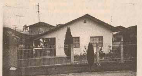
1171 - CASA DE ALVENARIA - CZERNIEWICZ - c/ 66,13 m 2 em terreno de 357 m 2 tendo 1 qto, bwc, copa, cozinha, sala, despensa e lavanderia = R$ 49.000,00
