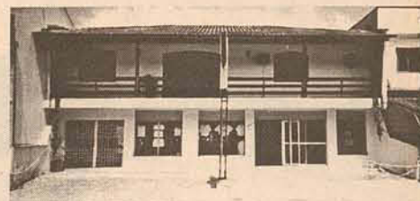
1213 - SOBRADO RESIDENCIAL/COMERCIAL - JARAGUÁ ESQUERDO - de frente p/ rua principal c/ 266,20 m 2 , tendo suite + 2 qtos, sacada, sala comercial = R$ 130.000,00 .
