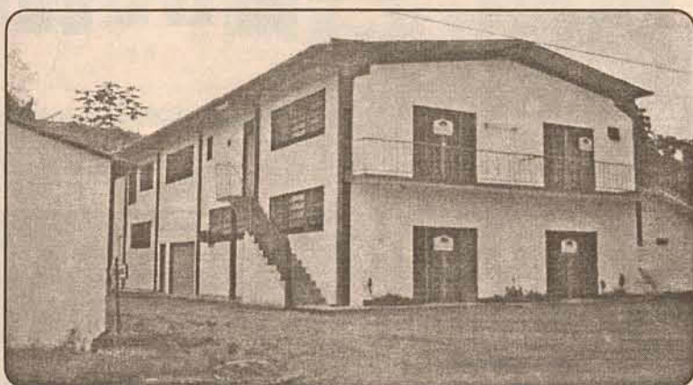
ALUGA - Galpão + apartamento. Rua Hinus Krause, 158, c/ 480,00m 2 Bairro: São Luiz. R$ 980,00
