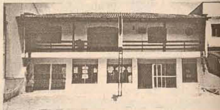
1213 - SOBRADO RESIDENCIAL/COMERCIAL - JARAGUÁ ESQUERDO - de frente p/ rua principal c/ 266,20 m 2 , tendo suite + 2 qtos, sacada, sala comercial = R$ 130.000,00.
