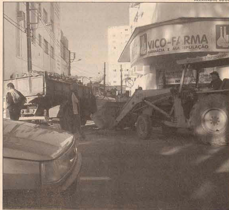
Aproximadamente 30 metros de tubulação foram colocados
