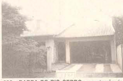
025 - BARRA DO RIO CERRO - construção de 144,50m² e terreno de 450,00m² - valor R$ 166.000,00.
