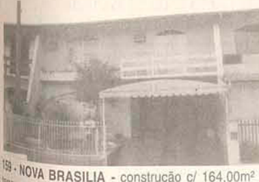
159 - NOVA BRASILIA - construção c/ 164,00m² e terreno c/ 168,00m² R$ 115.000,00
