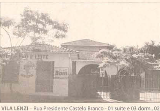
VILA LENZI - Rua Presidente Castelo Branco - 01 suite e 03 dorm., 02 banheiro, peça comercial, área const. 234m 2 , terreno 510,00m 2 R$ 90.000,00.
